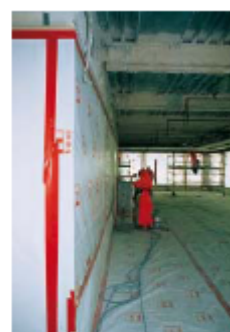
Chantier de désamiantage
