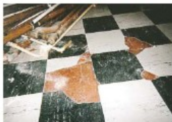
Dalles de sol
