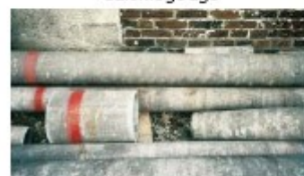
Canalisation en amiante-ciment
