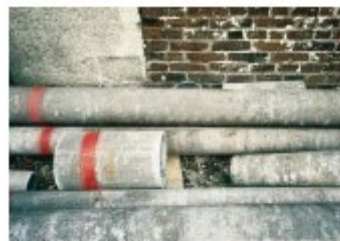
Canalisation en amiante-ciment
