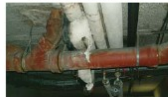
Calorifugeage
